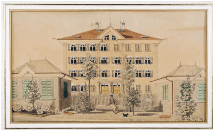
Der Honnerlagsche Palast präsentiert sich heute wieder fast genau so wie ca. 1822 auf diesem Federquarell von Johann Ulrich Fitzl (Bild: wikipedia commons)
